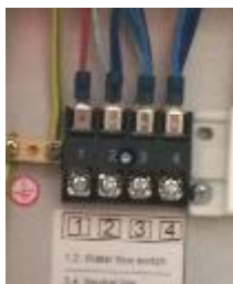
Raccordement du flow-switch Bornes 1 et 2 Raccordement circulateur mono Bornes 3 et 4
