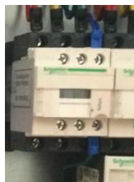
Raccordement du flow-switch Bornes 1 et 2 Raccordement circulateur mono Bornes 3 et 4
